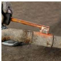
Izplūdes cauruļu noņemšana
