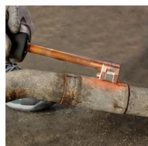
Izplūdes cauruļu noņemšana
